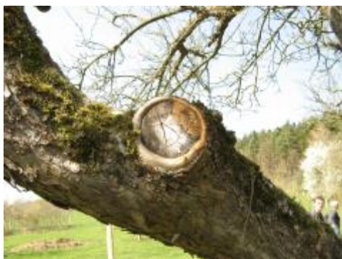
Große Schnittwunde am Altbaum birgt die Gefahr einer Pilzinfektion und spätere Bruchgefahr am Leitast
