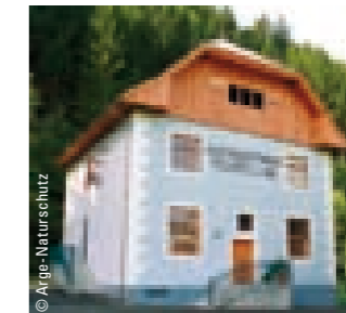
Fledermaushaus nach der Renovierung
