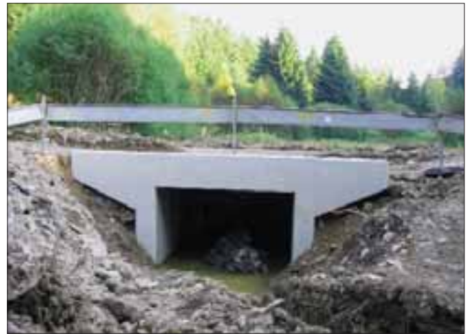
Abb. 33: Zur Wiederherstellung der Durchgängigkeit von Fließgewässern werden Bachverrohrungen unter Wegequerungen durch breitere Durchlässe ersetzt (Foto: A. Pardey)
