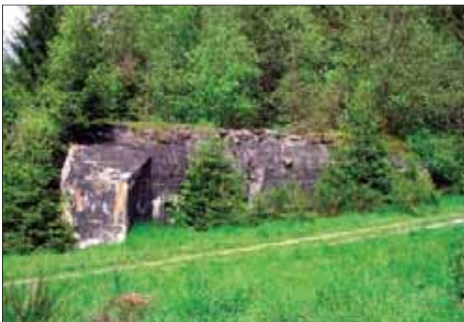
Abb. 43: Ausgewählte Bunker sollen vom Land übernommen, erhalten und verkehrssicher verschlossen werden (Foto: A. Pardey)
