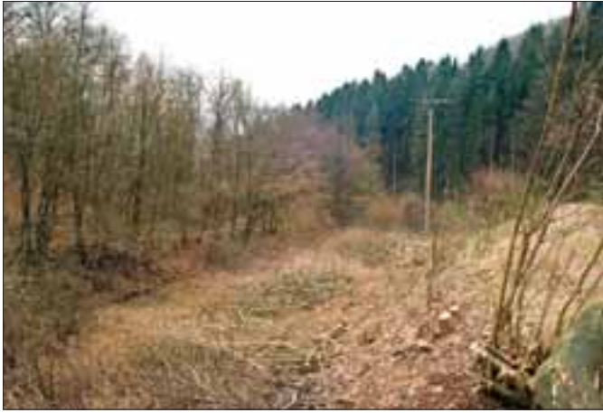
Abb. 89: Leitungstrassen (Lompigtal südlich Schleiden-Wolfgarten) müssen durch periodische Unterhaltungsmaßnahmen frei gehalten werden und stellen Störungen des Landschaftsbildes sowie Gefahrenpunkte für die Tierwelt dar. (Foto: A. Pardey)
