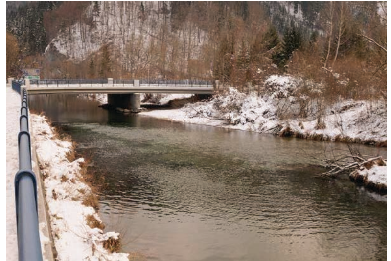
Abb.4 – Traisenbrücke in Freiland, Ende Abschnitt IV
